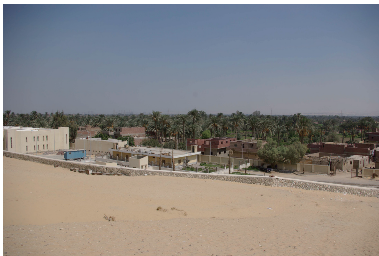
Fig.6 建設中の北の施設群
